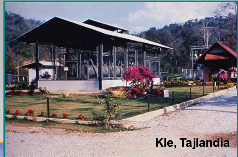
Połączenie elektrowni binarnej i układu pary mokrej.
